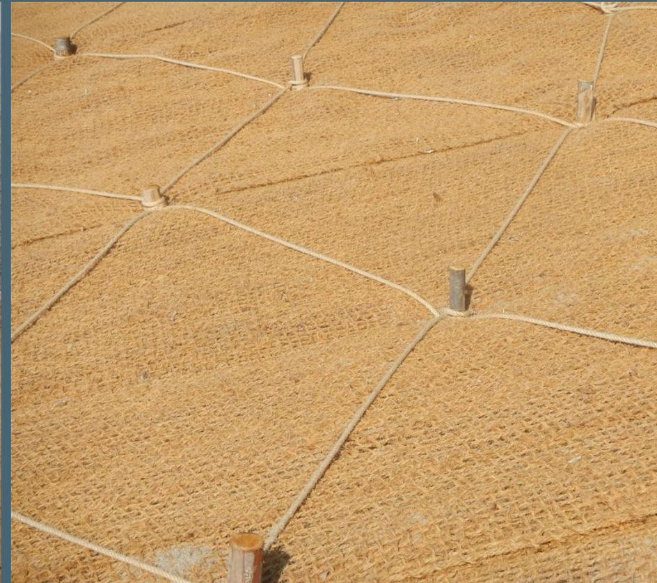
Il piede della duna è stato protetto con moduli a scacchiere di canna di fiume, utili anche a intrappolare le sabbie.
