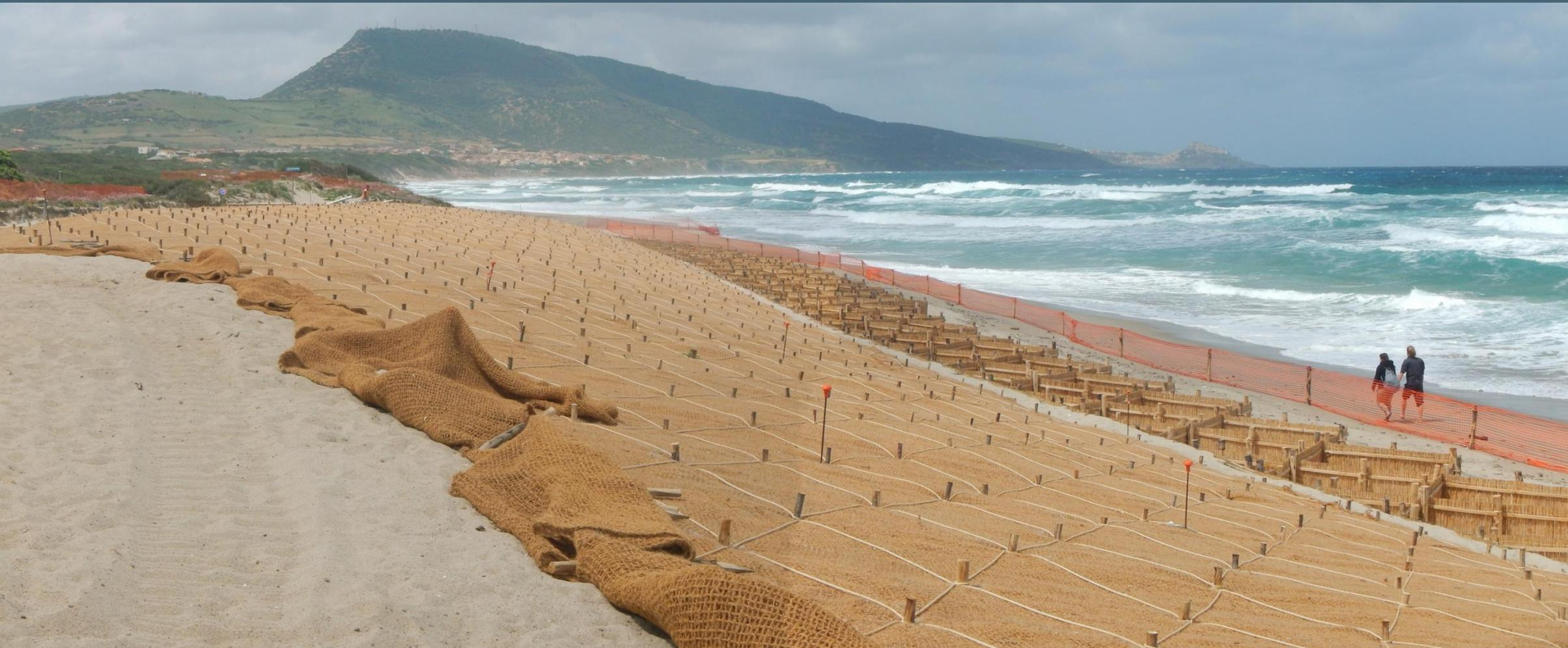
Ed è stata protetta con georeti in fibra di cocco e stuoie di lana vergine di pecora autoctona sarda.
